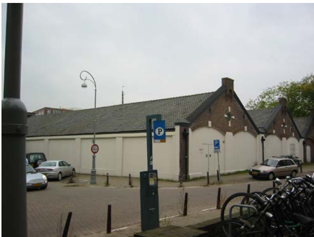
entree Entrepotdok: mooie gebouwen, saai openbare ruimte.
